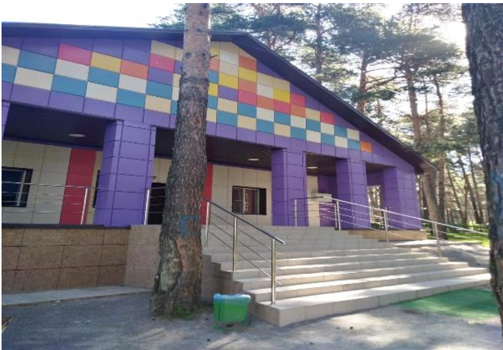
Корпус ДПО (8 корпус)
